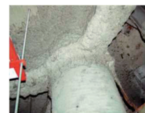
吹付け石綿 （鉄骨材の耐火被覆）
